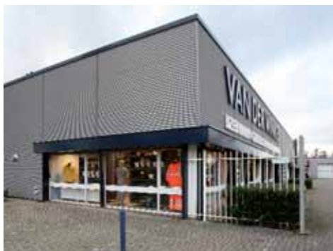
Met metalen daken en gevels bouw je in een korte periode een nieuwe schil om een pand, zoals hier bij Van der Winkel in Eindhoven.
