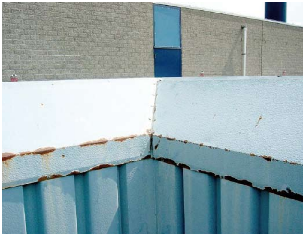
Roestvorming bij een gecoate metalen dakrand.
