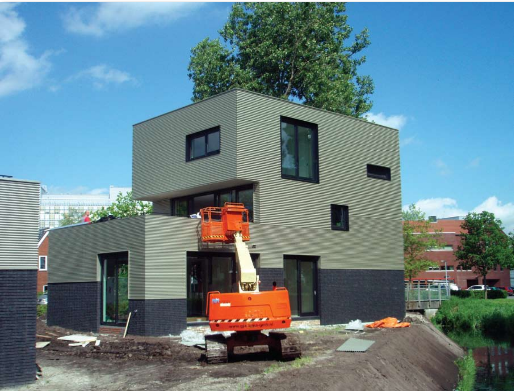
Metalen gevels en daken worden steeds meer toegepast in niet-industriële gebouwen.
